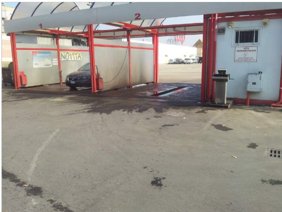
Figura 1- Area su cui si intende realizzare nuovo pozzo di captazione acque sotterranee.
